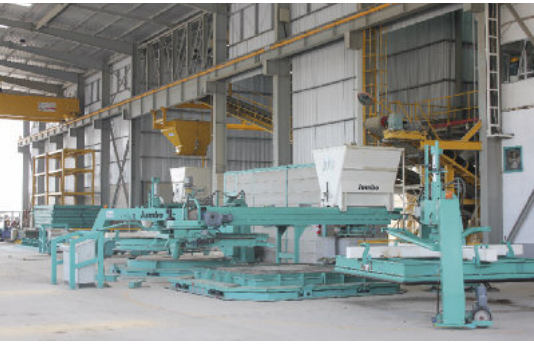
Maszyna Jumbo Duo do produkcji rur, elementów studzienek i przepustów skrzynkowych.
