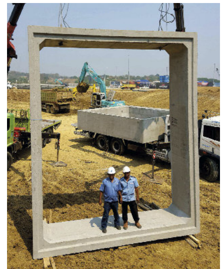
Przykład przepustu skrzynkowego wykonanego na wielkowskrajowym stole wibracyjnym Mammut.
