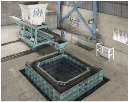
Produkcja przepustów skrzynkowych i dużych podstaw studzienek na stole wibracyjnym Mammut.
